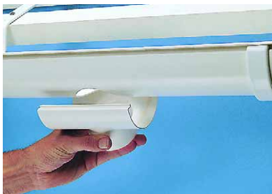
13. Žlabový výstup převlékněte přes zadní okraj okapového žlabu a zamáčkněte přes horní okraj.
