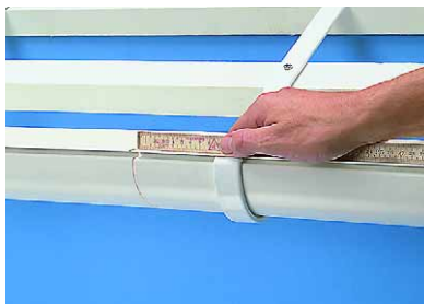
14. Spojovací kus (kat. č. 6). Vlivem teplotních změn mění okapové žlaby svoji délku. Z tohoto důvodu musí mít možnost pohybu ve žlabových háčích. Je nutné dodržet minimální vzdálenost 90 mm mezi žlabovým hákem a spojem. Okapový žlab přizpůsobte při montáži na odpovídající délku.
