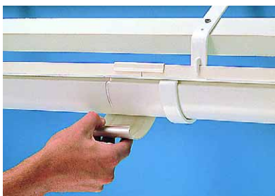
16. Spojovací kus převlékněte přes zadní okraj okapového žlabu a zamáčkněte přes přední okraj.
