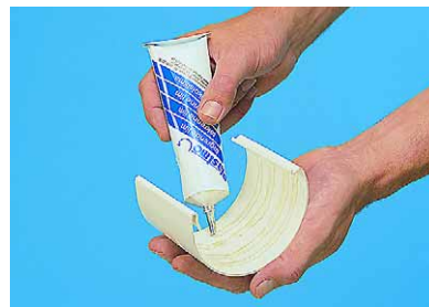
15. Při spojování srazte oba žlaby nadoraz. Na spojovací kus naneste lepidlo ve čtyřech prouzcích o šířce 5 mm (krajní naneste 10 mm od hrany).
