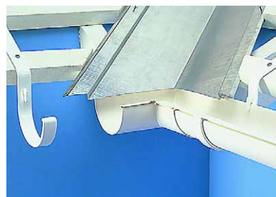
18. Okapový žlab splepený s rohem upevněte do žlabových háčků. Potom naneste stejným způsobem lepidlo na druhou polovinu rohu a splepte s okapovým žlabem.
