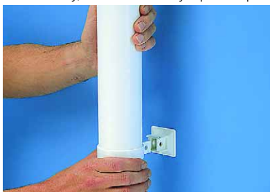
22. Trubková objímka (kat. č. 30, 31, 32). Horní objímku stáhněte napevno pod kolémem. Trubka tak v podstatě na horní objímce visí. V ostatních objímkách směrem dolů se musí trubka pohybovat volně. Tím je umožněna dilatace materiálů.
